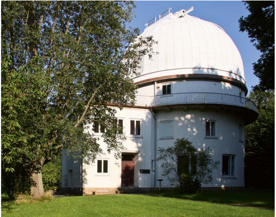
Kuppelgebäude des Oskar-Lühning-Teleskops in Ritchey-Chrétien-Bauweise mit 1.2 m Öffnung und 15.6 m Brennweite.
